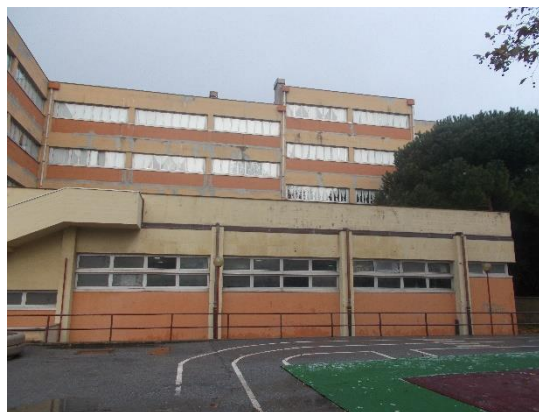
Figura 1.1 - Vista della facciata
