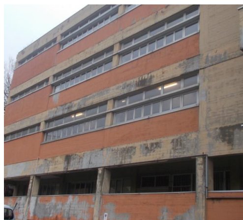
Figura 8.1 – Particolare di una facciata
