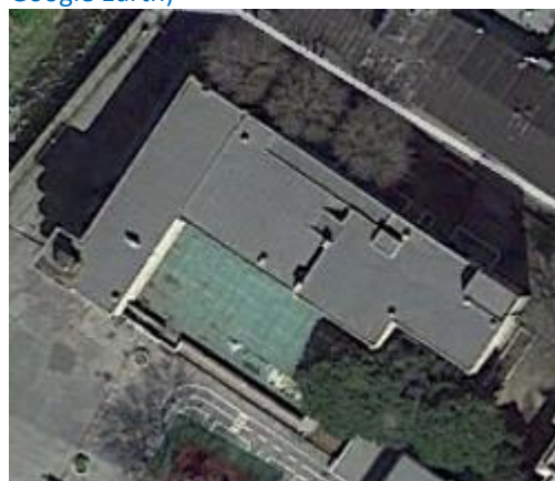
Figura 2.2 - Vista satellitare dell'edificio (Fonte: Google Earth)
