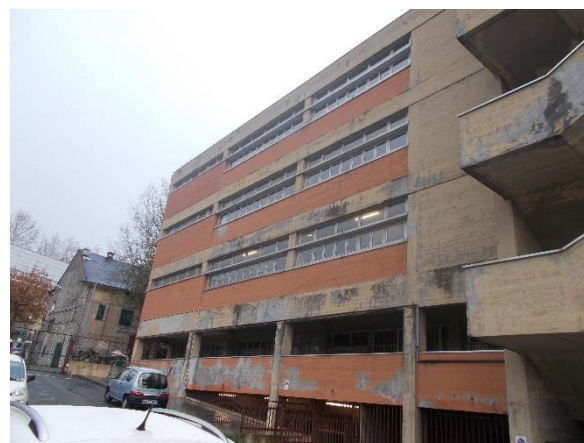
Figura 4.2 - Particolare della facciata
