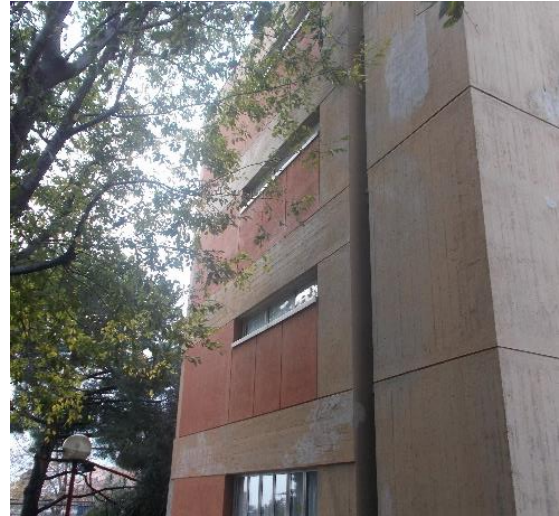
Figura 4.4 - Particolare dei serramenti
